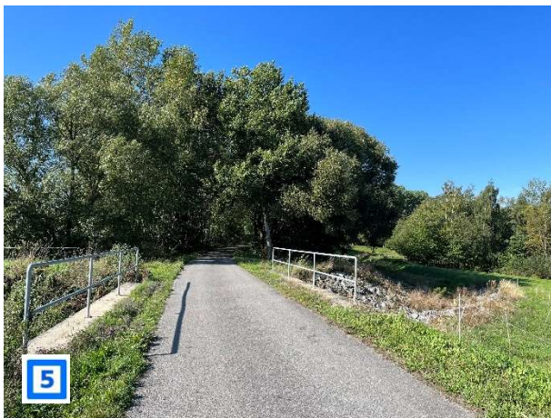
protipovodňové opatření jihozápadně od Ledenic
