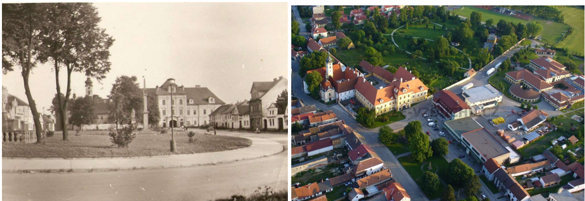
Obr. Historická silueta Borovan (zdroj: Borovansko – oficiální turistický portál města Borovany) v porovnání se současným stavem (zdroj: fotografie www.ze-vzduchu.cz )
