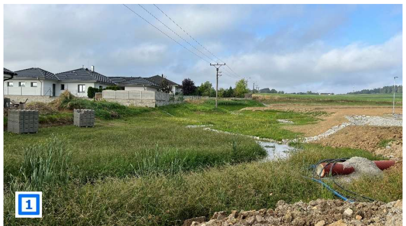
Revitalizace místní vodoteče a výstavba ZTV pro novou obytnou lokalitu
