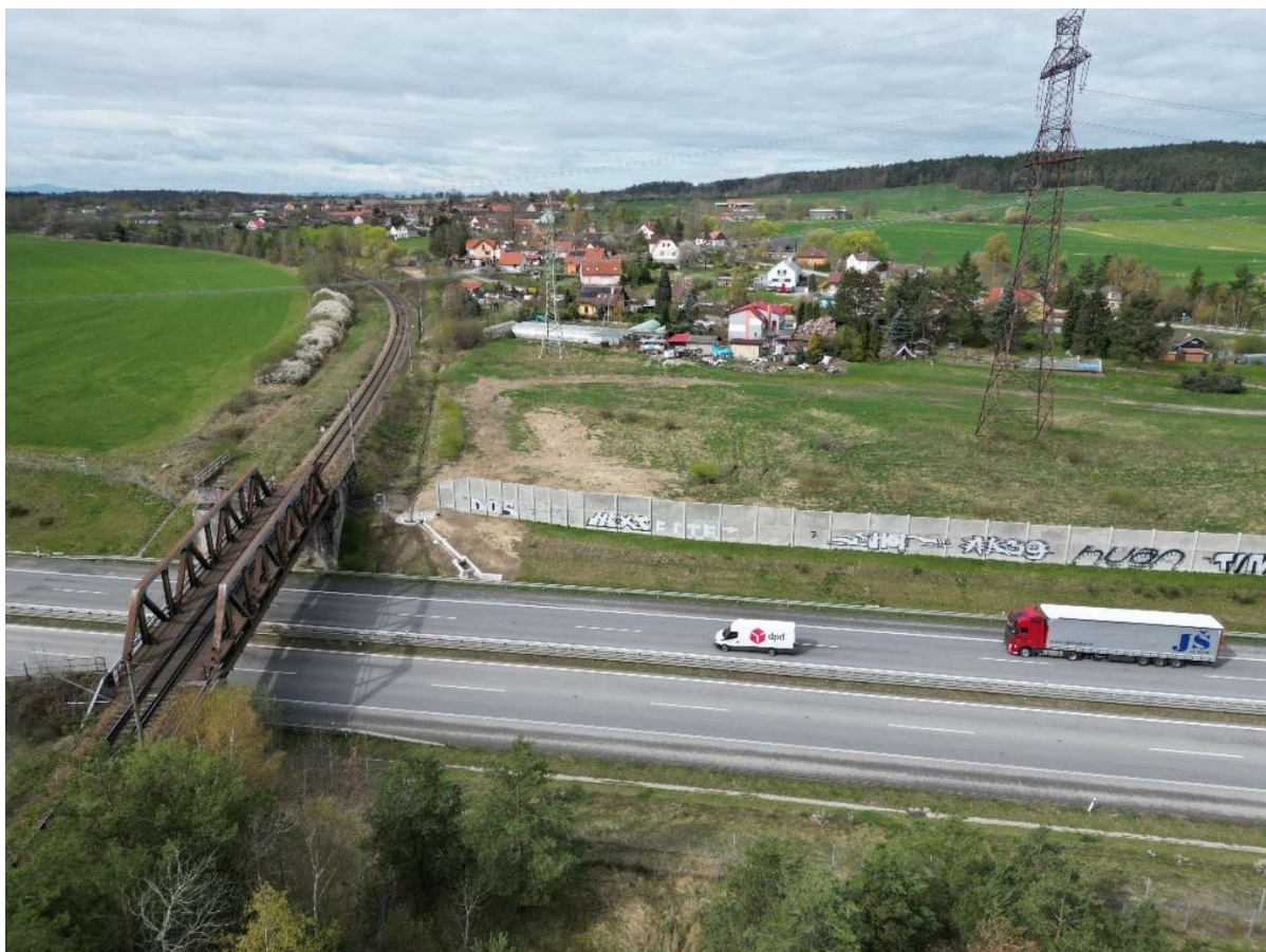
Stávající železniční most mezi obcemi Ševětín a Vitín
