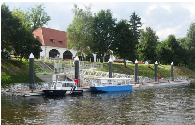
Obrázek 5: Přístaviště Lannova loděnice v Českých Budějovicích
